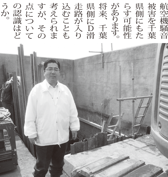
護岸整備の現場を視察
