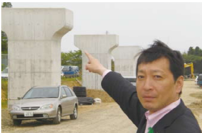
北千葉道路の工事状況を現地調査(成田市大谷津付近)
