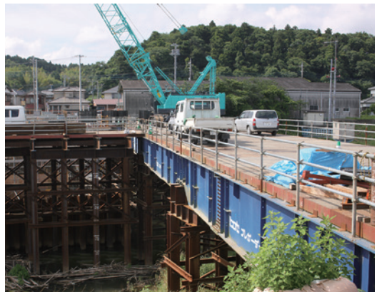
工事中の富川橋
