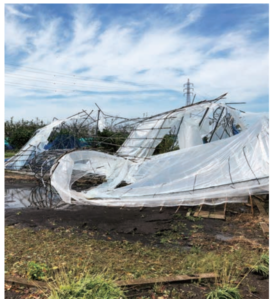
15号の強風で破壊されたビニールハウス
