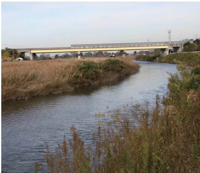
土砂の堆積で雑草が生い茂る小櫃川 (袖ヶ浦市横田付近)
