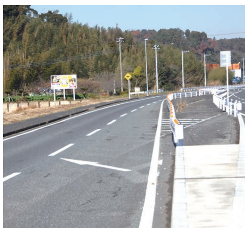
この先は未整備区間
