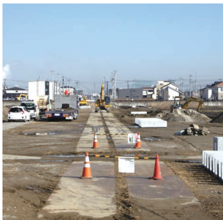
工事中の都市計画道路
