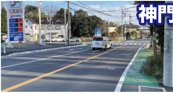
完成した神門交差点右折レーン
