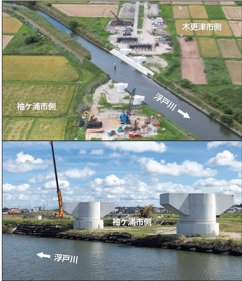
着々と進む浮戸川の橋梁工事
