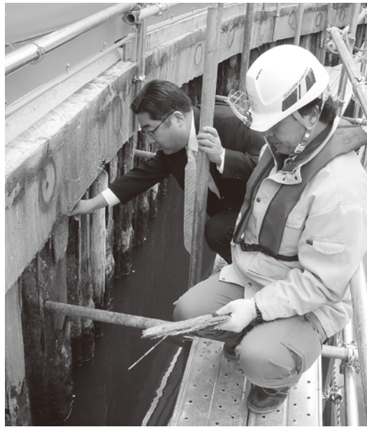
境川護岸工事現場を視察する内田県議
