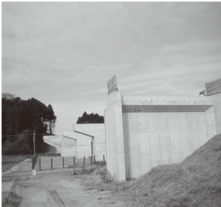
JR東金線跨線橋付近
