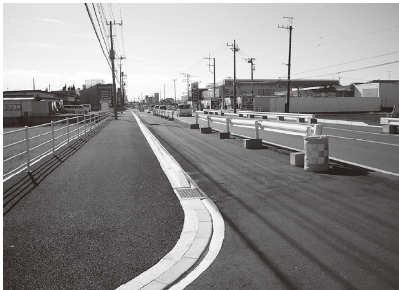
進む国道128号の改良工事
