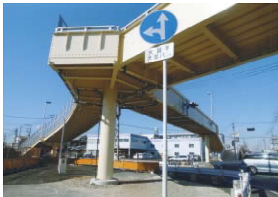
架け換えされた横断歩道橋
