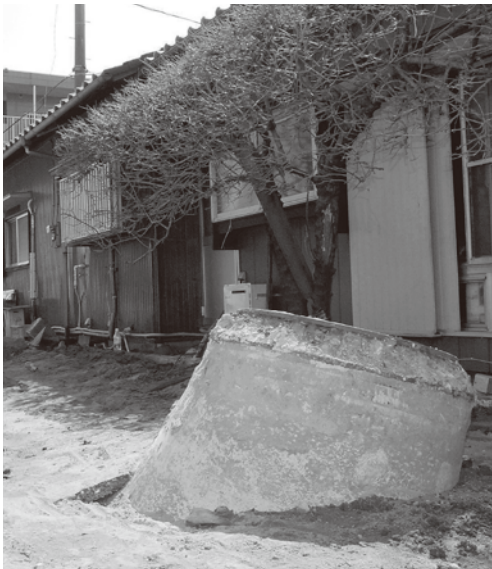
液状化によって道路から隆起したマンホール(我孫子市)※
