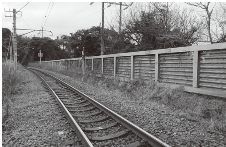
完成した内房線の防風柵
