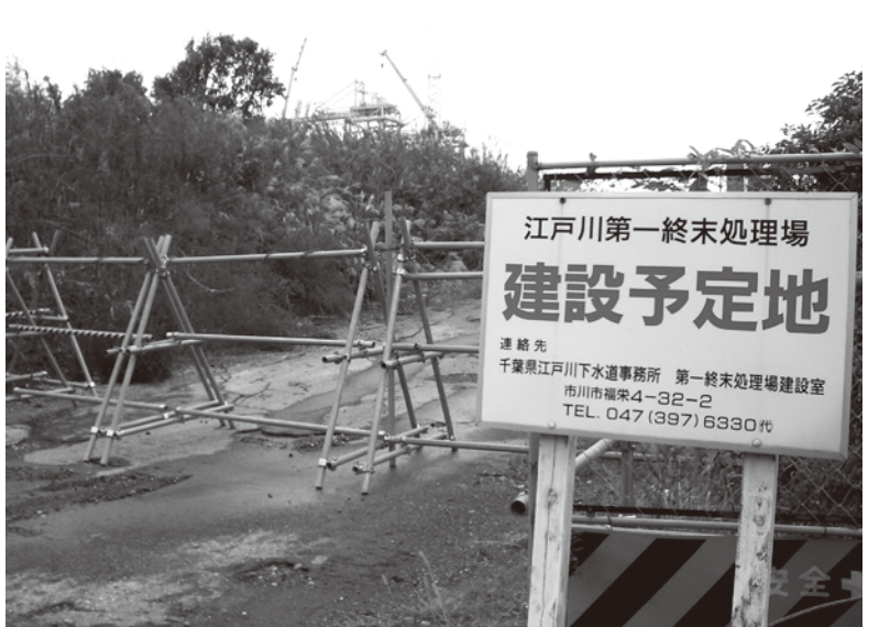
工事に着手された江戸川第一終末処理場建設地
