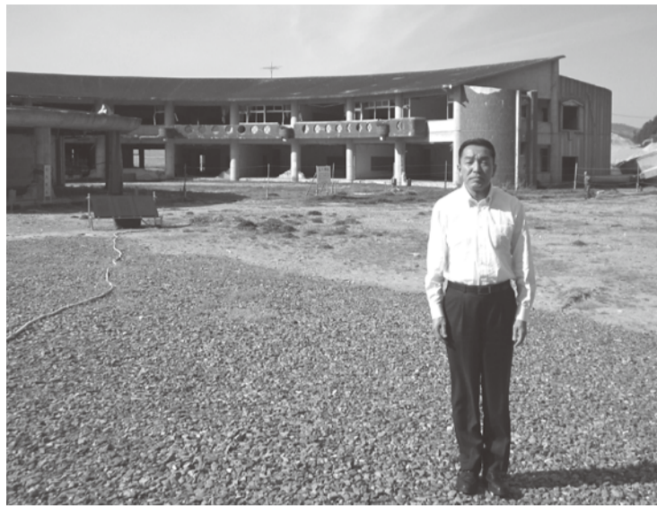
津波の爪跡も痛々しい石巻市大川小学校跡 ＝地震・津波対策議員連盟視察
