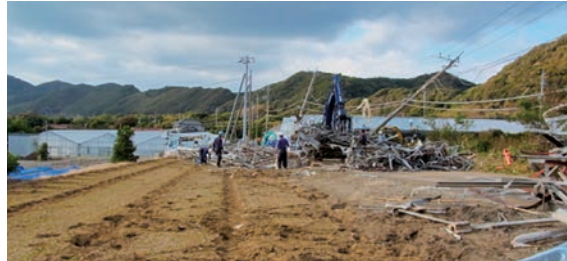
上:ビニールハウスが壊れたいちご畑。下:手前の畑にあったハウスが風で飛び、道の向こう側の電柱を倒している。
