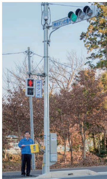
更科小学校信号機設置
