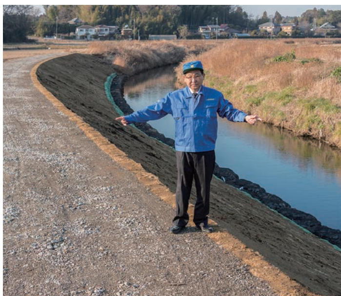
鹿島川の護岸整備 推移状況
