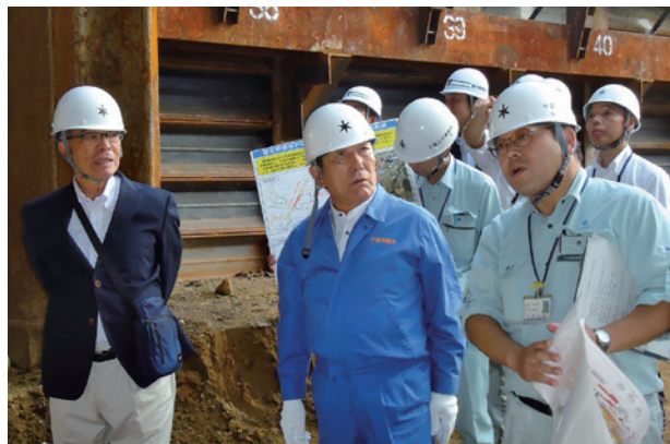
東習志野実綱線の工事現場を視察する佐藤県議
