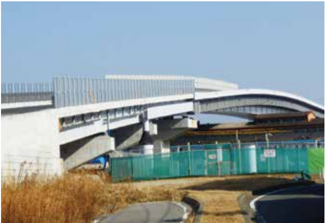
建設中の妙典橋(仮称)
