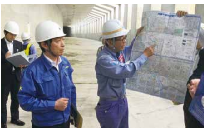
東京外環道・市川JCT工事状況を視察
