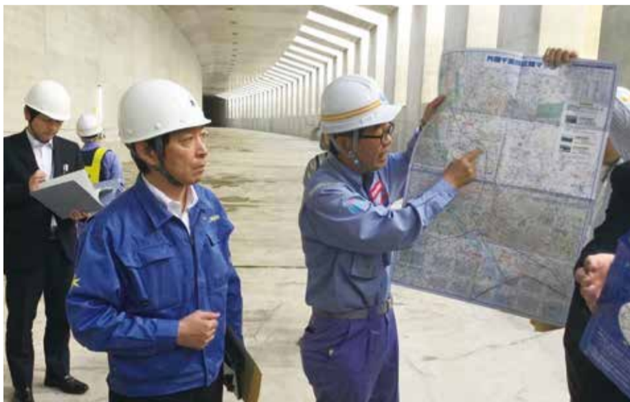
6月開通予定の東京外環道・市川JCT工事状況を視察する滝田敏幸県議
