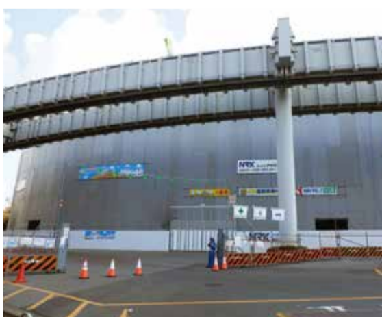
工事シートで覆われ、改修中の県野球場
