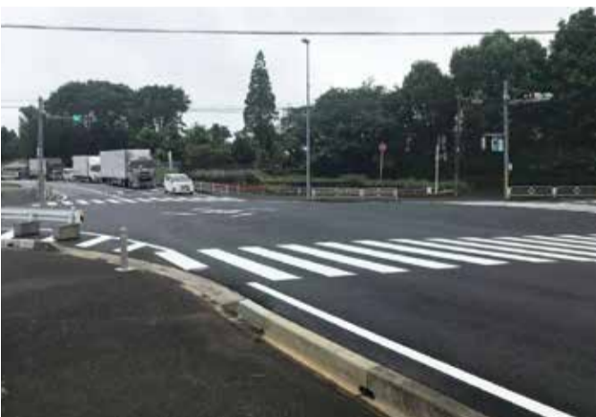
▶工事が終わり、段差が解消した交差点
