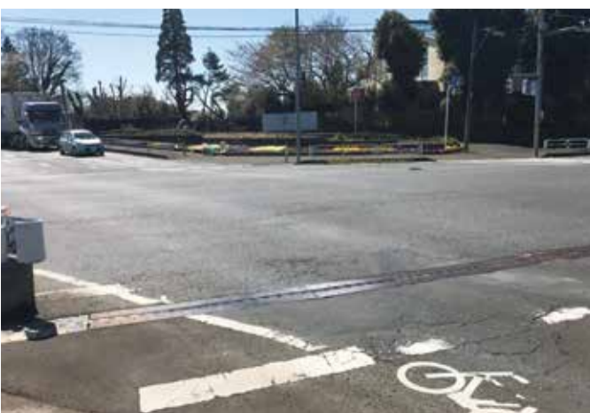
▶側溝が国道両側を横断していた改良前の交差点
