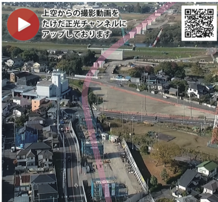
橋脚・橋台 全25基中 11基完成 11基工事中 3基今年度発注予定
