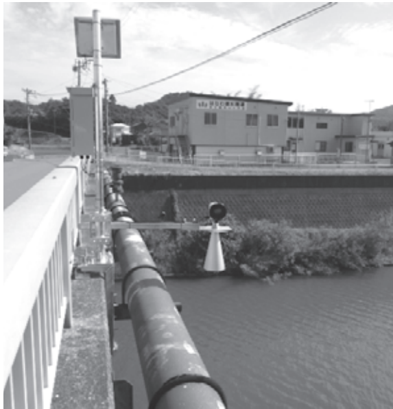
危機管理型水位計(右側の突出部)
