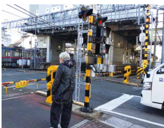
歩行者の安全を守る踏切だが、大地震発生時には長時間、遮断の懸念も
