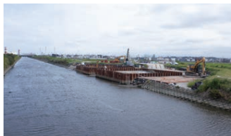
西内河根場線・袖ヶ浦市側の橋脚工事
