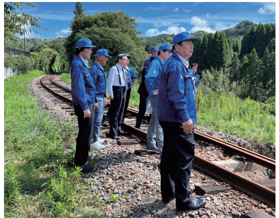
いすみ鉄道軌道敷の崩落現場を視察する阿部県議(Yシャツ姿)
