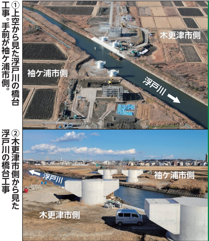
①上空から見た浮戸川の橋台工事。手前が袖ヶ浦市側。②木更津市側から見た浮戸川の橋台工事
