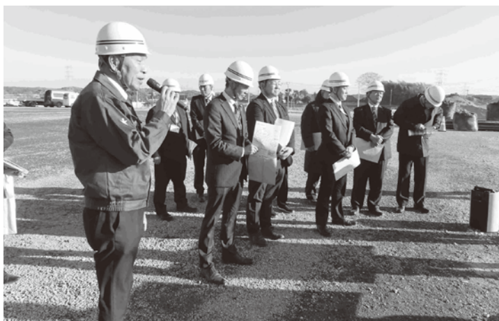
圏央道推進議員連盟として 県内の圏央道建設現場を視察
